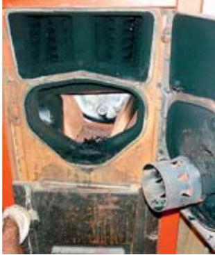
Asbestschnur als Dichtung
