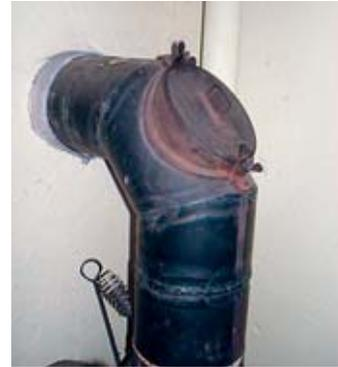
Mauerdurchführung mit Asbestzementrohr
