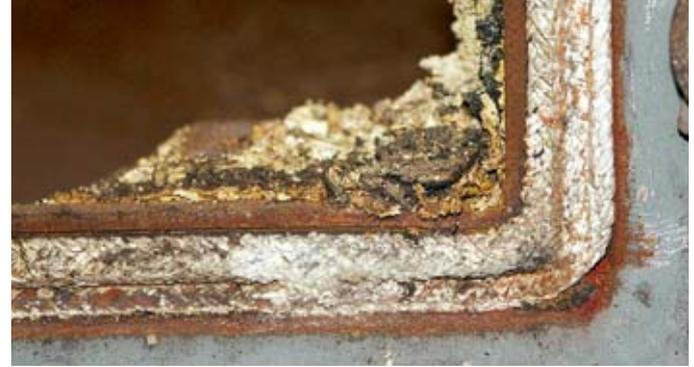
Asbestschnur als Dichtung
